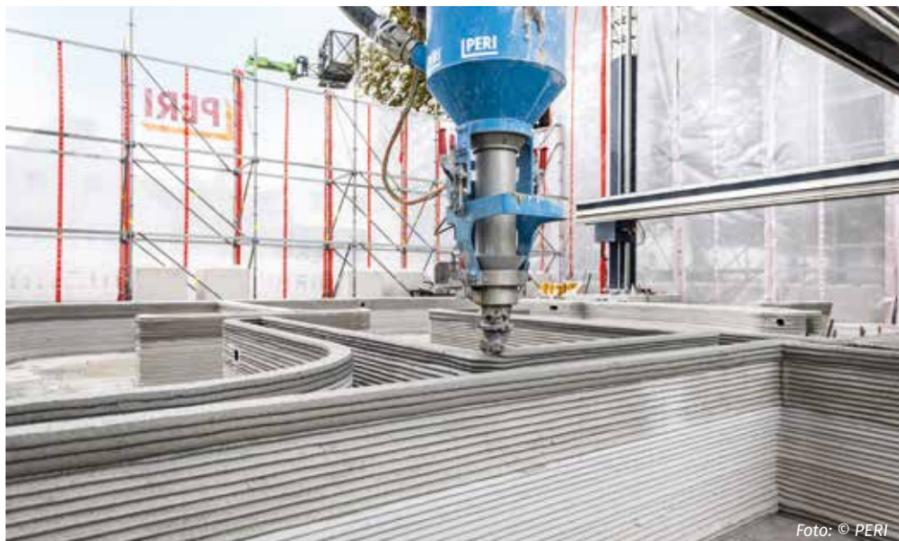
Gedruckt wurde das Gebäude mit einem speziellen PERI-Portaldrucker. Da der Druck Schicht für Schicht erfolgt, ähnelt die Fassadenoptik einem Kammzugputz.
